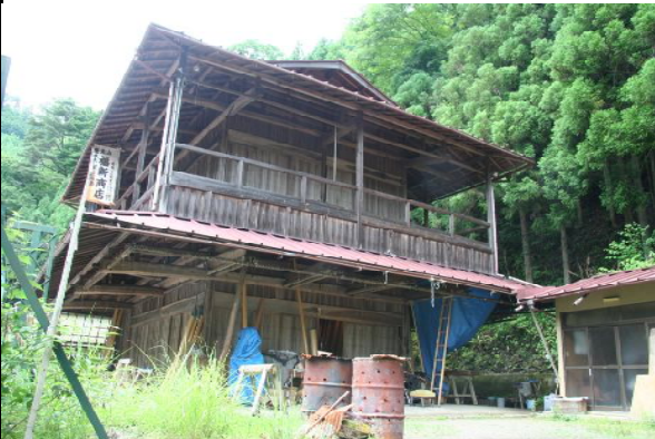
杉丸太小屋の外観事例
