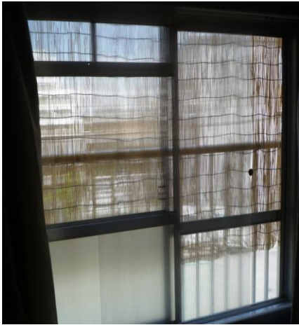
写真1 簡易内窓+すだれ設置
