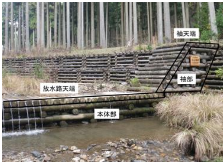
写真1 部材採取した木製治山ダム
