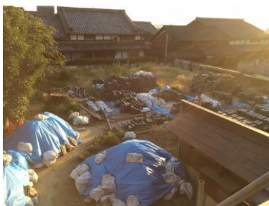
資材置き場となっている現敷地
