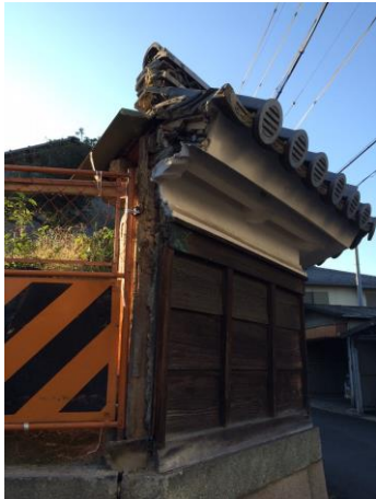
長塀修築前の状況
