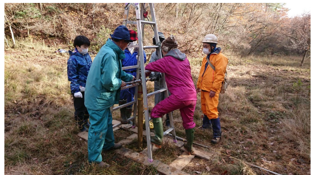
ボーリング調査風景
