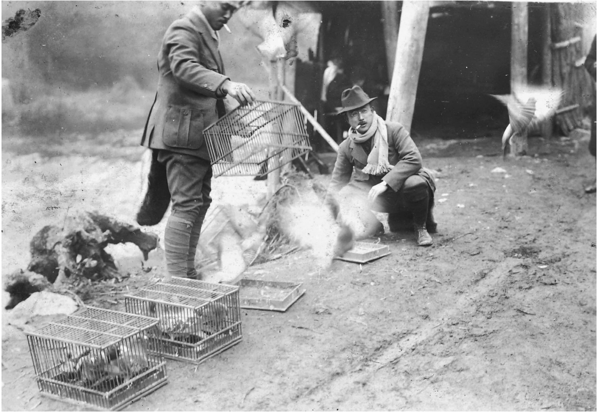
03. 雲ヶ畑川沿いの家で鳩を放つ両宮。 背中から脚にかけて毛皮製のものがみえる。山伏や山作業者が座る時に敷く引敷のようなものである。
