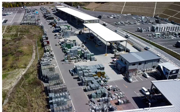
ドローンカメラで撮影した工場風景
